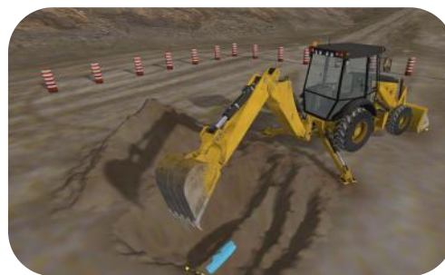
Dégagement de conduite souterraine – Parallèle
