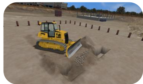
Remblayer la tranchée
